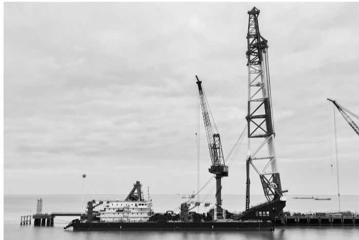
这艘打桩船可实现深远海厘米级精度打桩
