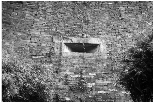
华严岗门北侧16号城墙暗堡射击口
