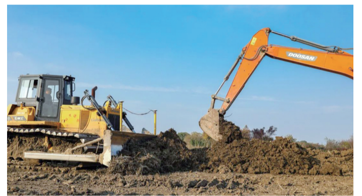
丹金高速常州段施工现场 常州交通供图
