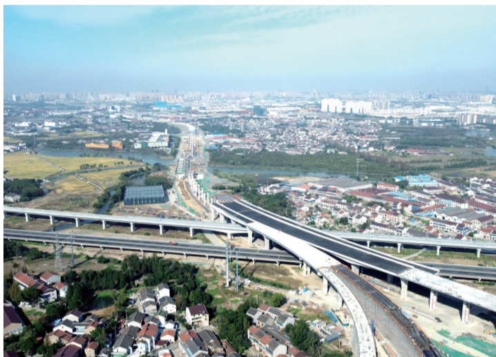
G312快速路施工现场 通讯员供图
