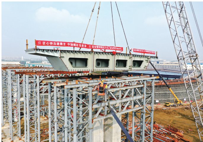
施工现场 通讯员供图
