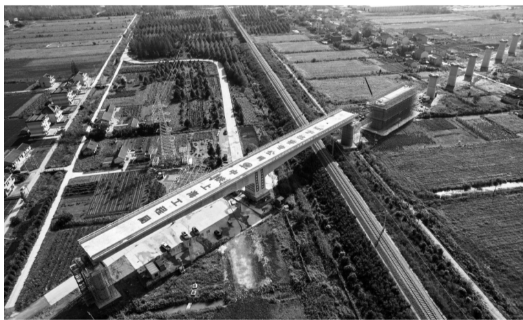
启东特大桥跨宁启铁路转体连续梁成功转体 孟凡琼 摄
