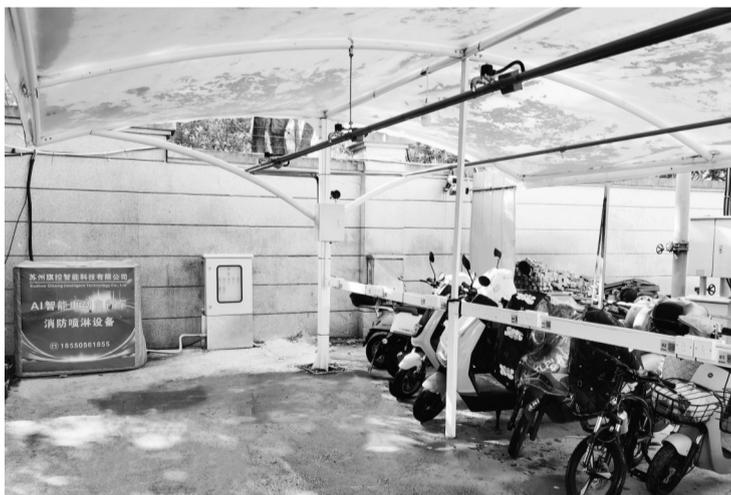
电动自行车以其便捷、环保的特点，是很多人日常出行的首选交通工具。然而，随着电动自行车数量的激增，其火灾隐患也日益凸显，电动车起火、燃爆等安全事故频发，给人们的生命财产安全带来严重威胁。据苏州旗控智能科技有限公司研发创始人余乐乐介绍，传统消防喷淋系统是物理式接收信号，火焰燃烧2至3米后烧到喷淋头，温度达到68℃以上融化喷淋头玻璃管后，才能启动单个喷淋头。而目前市场上电动自行车大多使用锂电池，相比常规火灾燃烧速度更快、持续时间更长，并且更容易发生爆燃和复燃，当电池被刺穿后，2分钟便可引燃全车，火势发展较快且不易控制。
