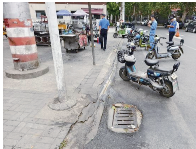
执法人员在处理乱倒污水行为 通讯员供图
