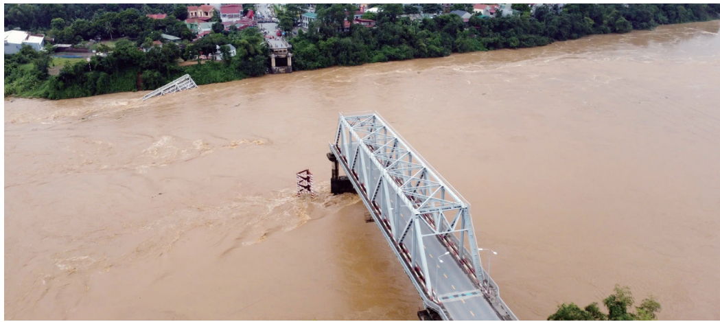
9月9日,越南北部富寿省一座钢桥倒塌(航拍照片) 新华社/越通社
