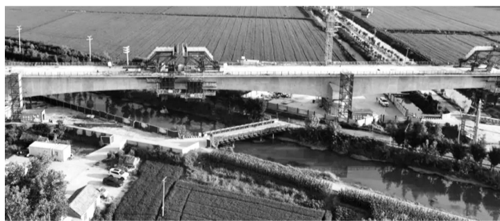
建设中的宁淮城际铁路 图片来源:江苏交通
