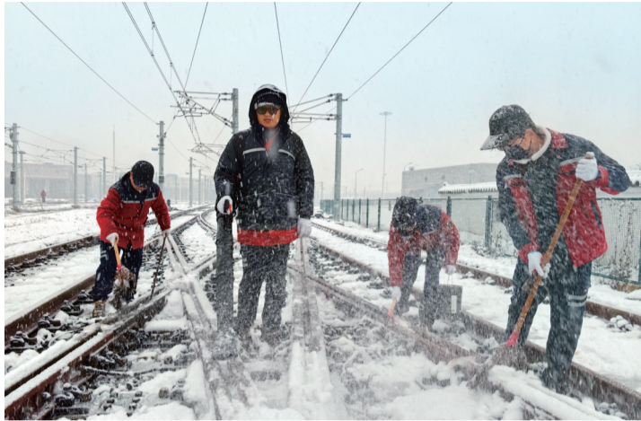
轨道专业扫雪除冰 常州地铁集团供图
