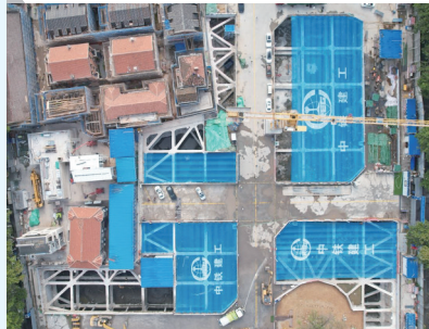
钟岚里工地安装了“天幕系统” 通讯员供图
