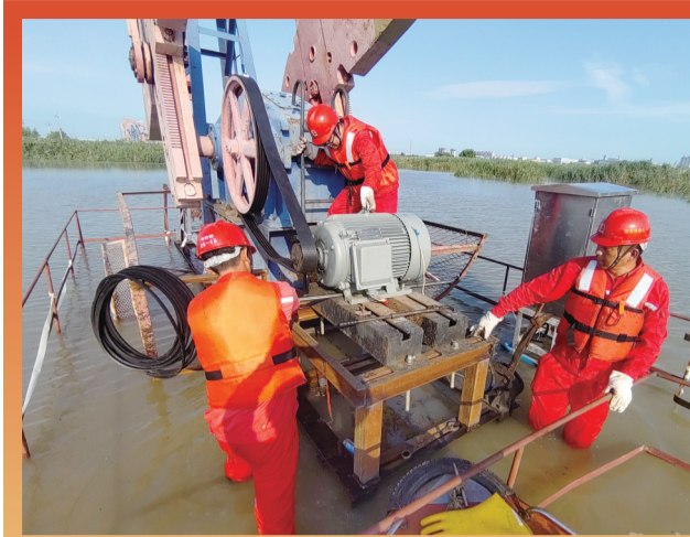
采油工人在维修采油设备 通讯员供图
