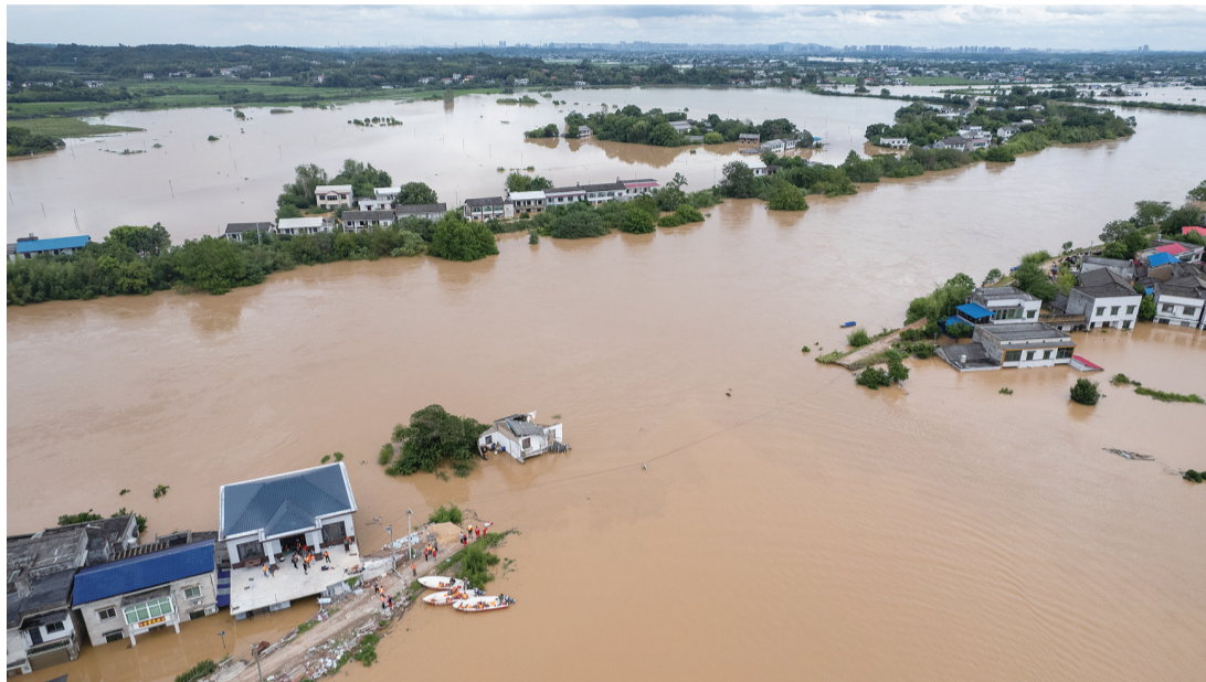
湘潭县易俗河镇四新堤决口现场 新华社发
