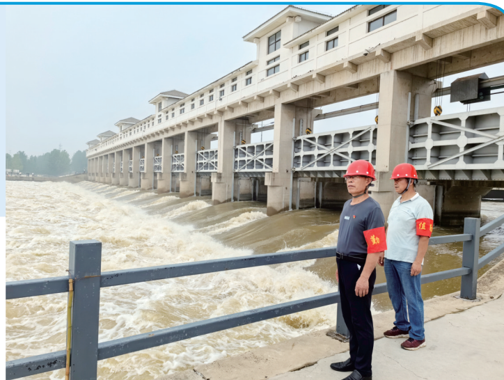
万清绪(左)和同事在闸下查看泄洪情况 通讯员供图
