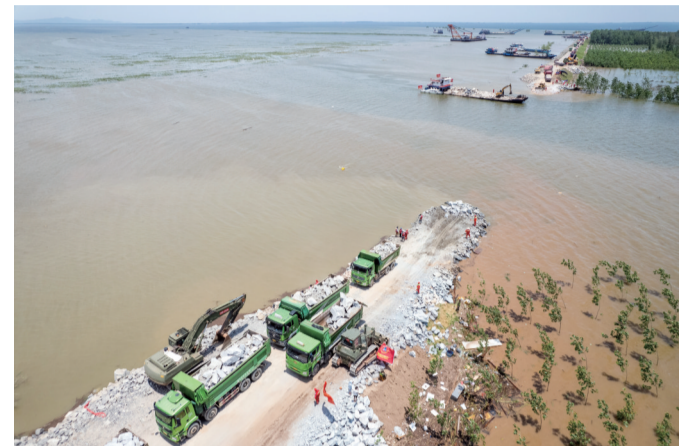
7月7日,在湖南省岳阳市华容县团洲垸洞庭湖大堤决口现场,抢险队伍在进行堵口作业(无人机照片) 新华社发
