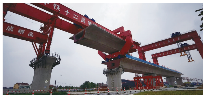
施工现场 通讯员供图
