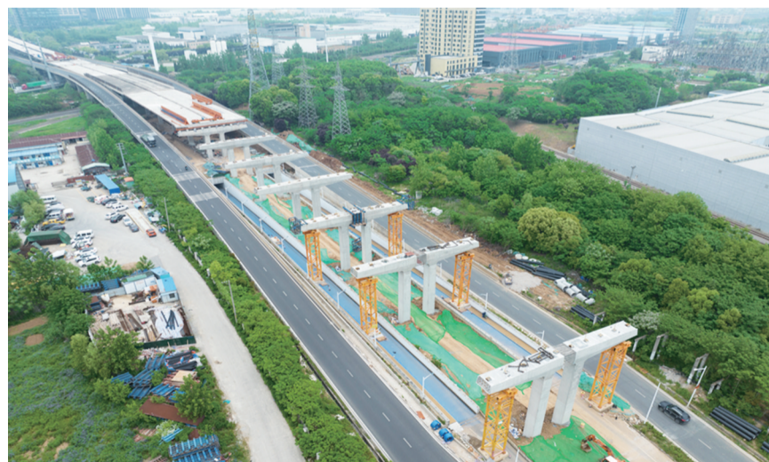
62跨架起“钢铁长龙” 图片来源:南京市城乡建设委员会
