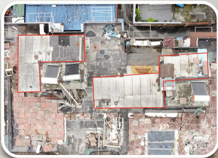
楼顶违建航拍图(红框内为违建)
