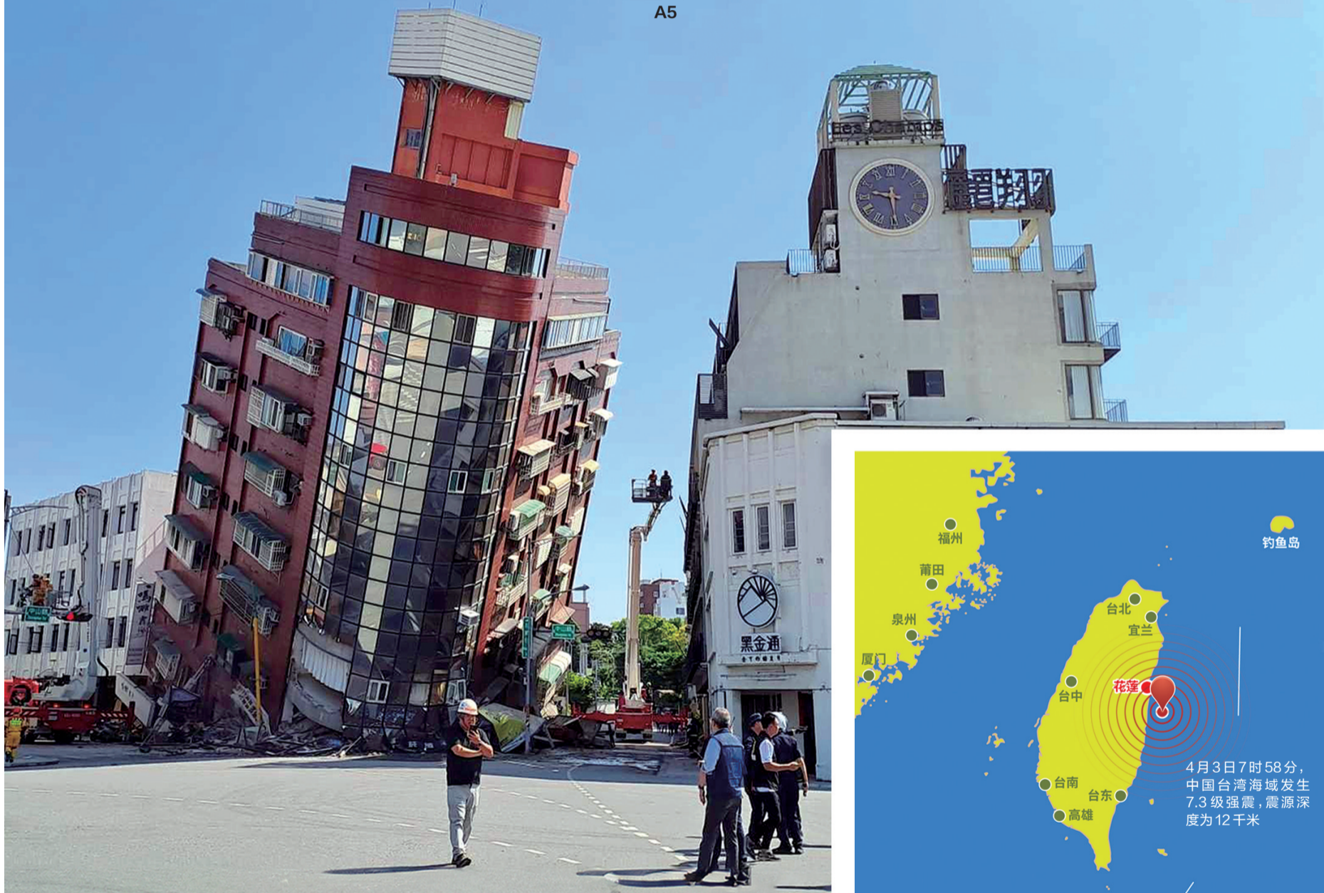
地震造成花莲一栋大楼严重倾斜(4月3日摄) 视觉中国供图
