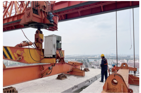
常泰长江大桥南接线工程施工现场 张磊供图
