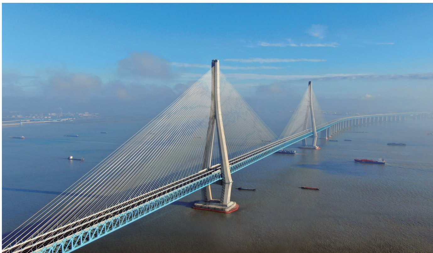
沪苏通长江公铁大桥(本版图片除署名外,由南通市委宣传部提供)
