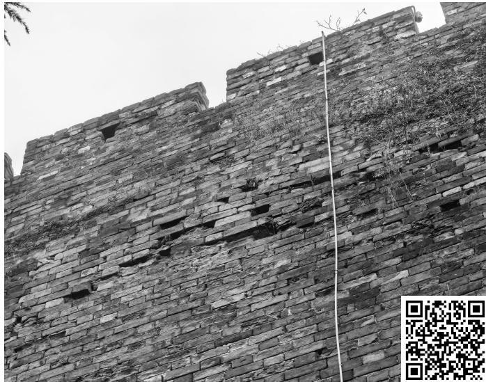
南京龙脖子段城墙墙体老化 扫码看视频
