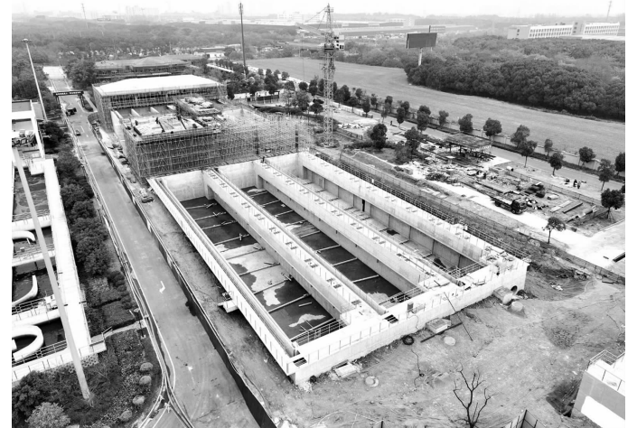
滨湖污水处理厂二期项目建设现场 通讯员供图
