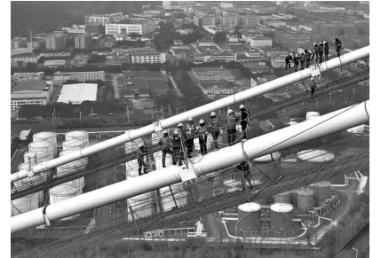
施工人员牵引检修道扶手绳 通讯员供图
