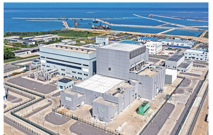
华能石岛湾高温气冷堆示范工程外景(资料照片) 新华社发(孙文湛 摄)
