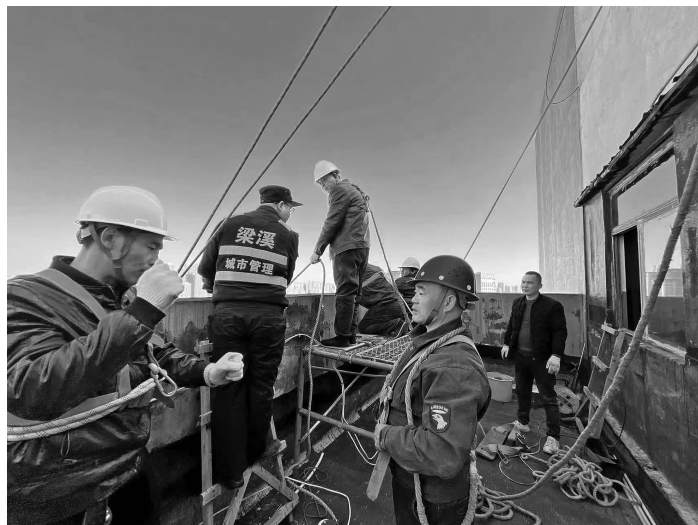
拆除高空广告 梁溪城管供图
