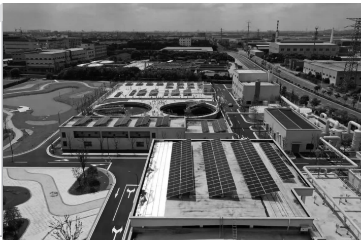
玉祁永新污水处理厂二期 惠山城管供图
