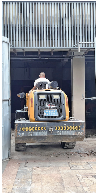
工作人员正在清理建筑垃圾
