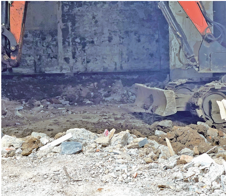
店铺内停放着一台挖掘机
