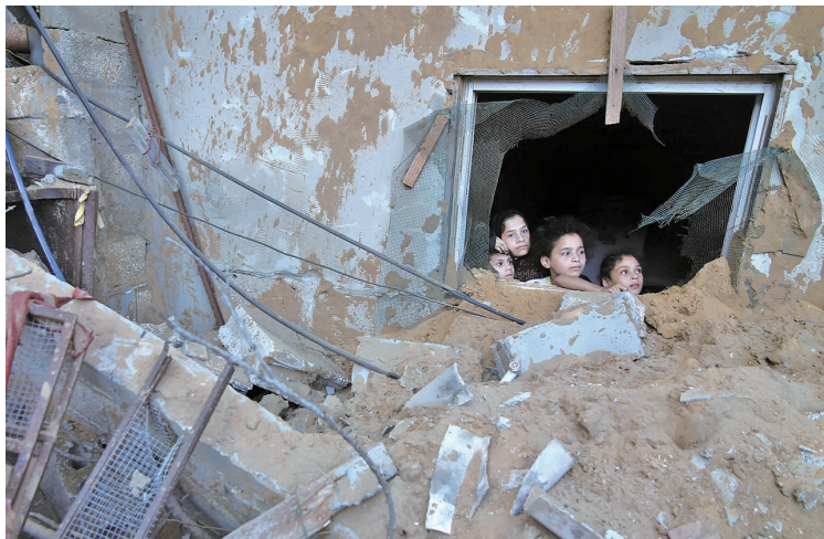
10月15日,在加沙地带南部城市拉法,儿童在遭以色列空袭受损建筑中张望 新华社发
