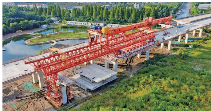
常泰南接线施工现场 通讯员供图
