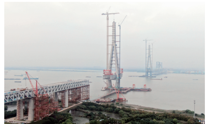
世界最高斜拉桥塔——高350米的常泰长江大桥南主塔封顶 省交建局供图
