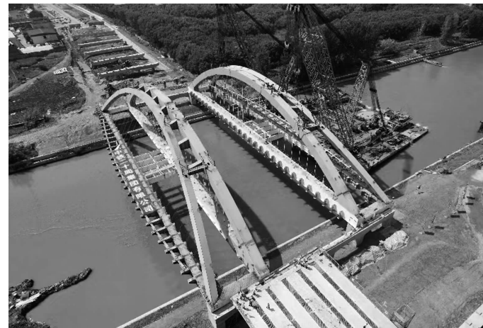
建设中的昆仓桥 常州交通供图
