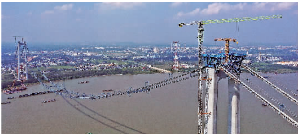
龙潭长江大桥主钢缆穿南北主塔 现代快报+记者 顾炜 摄
