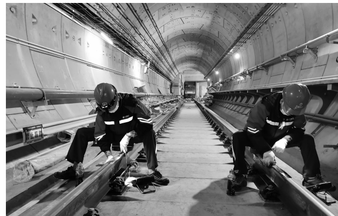
“钢轨医生”正在作业 无锡地铁供图
