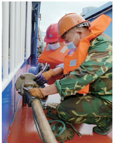
每次接收生活污水都要接上管道
