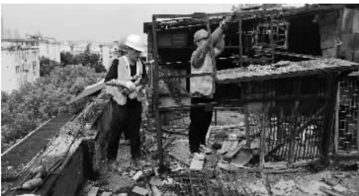
拆除现场 金阊街道供图
