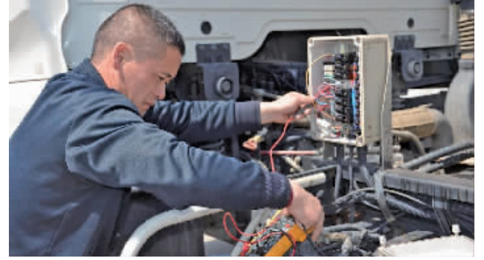
朱言春在垃圾填埋场维修设备 通讯员供图
