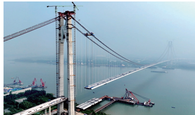
施工现场 通讯员供图
