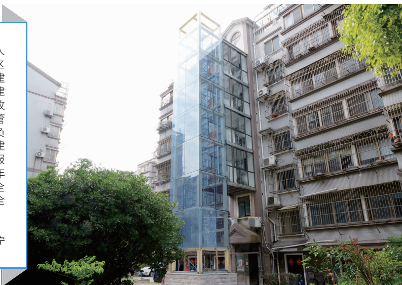
南通某老旧小区加装电梯 视觉中国供图
