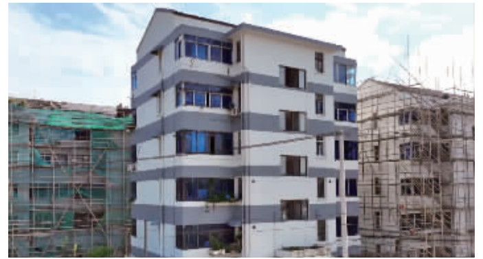
常钢宿舍改造中 通讯员供图
