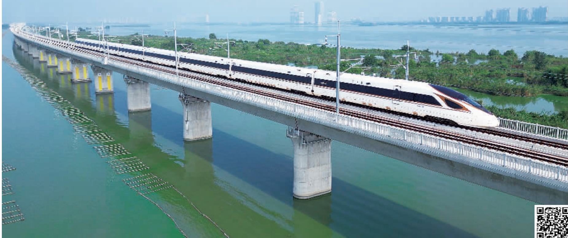
首趟试运行列车驶过常州特大桥漏湖段 陈苏青 摄 扫码看视频
