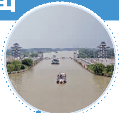
淮安水上立交枢纽工程
