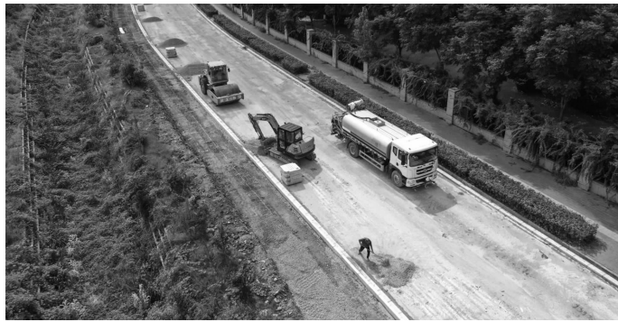
支十路改建施工现场 通讯员供图
