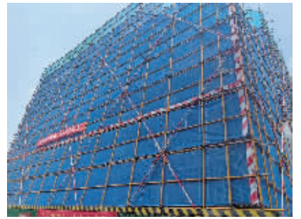
原汉中门汽车站施工现场
