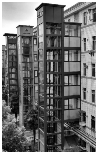
小区加装的电梯 通讯员供图
