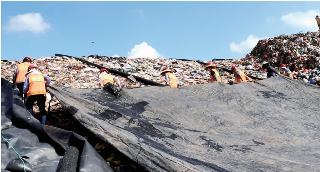
顶着烈日，铺膜工们正在给垃圾“穿衣服”，阻止异味散发 现代快报+记者 陈云龙 摄
