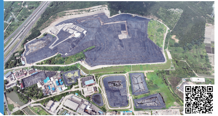
常州市生活垃圾处置中心俯瞰图 受访者供图 扫码看视频
