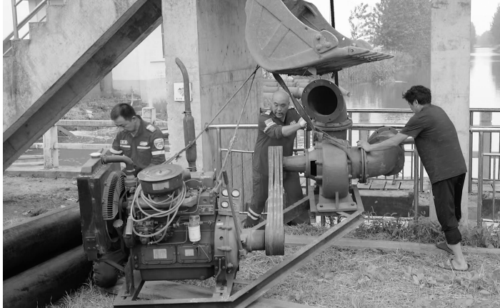
水利人员在安装设备排涝 通讯员供图
