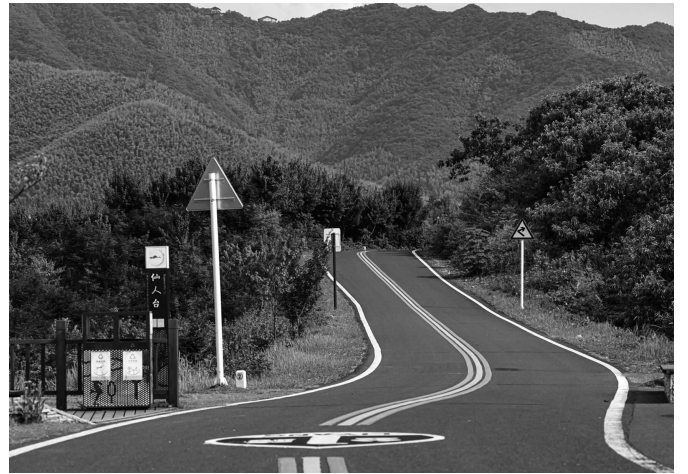
溧阳“1号公路” 通讯员供图
