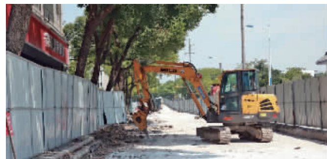
延陵东路提升改造 通讯员供图
