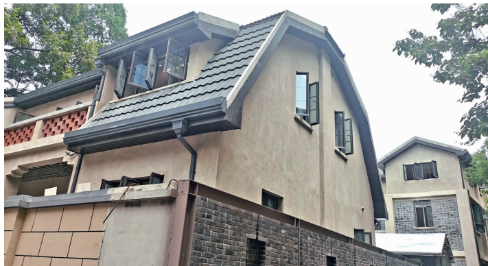
施工现场 现代快报+记者 蔡梦莹 摄
